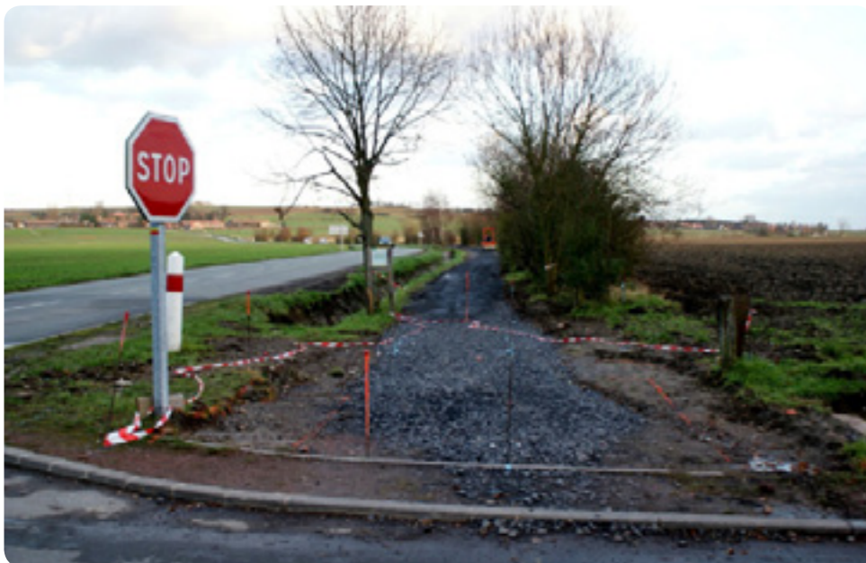
Réfection de la voie PP à Deux-villes
