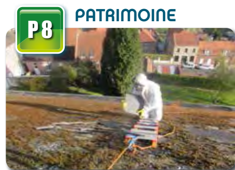
> Les travaux sur l'église ont commencé
