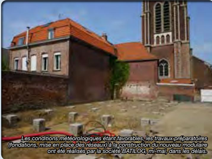
Les conditions météorologiques étant favorables, les travaux préparatoires (fondations, mise en place des réseaux) à la construction du nouveau modulaire ont été réalisés par la société BATILOG, mi-mai, dans les délais.
