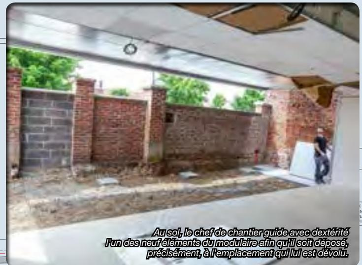
Au sol, le chef de chantier guide avec dextérité l'un des neuf éléments du modulaire afin qu'il soit déposé, précisément, à l'emplacement qui lui est dévolu.
